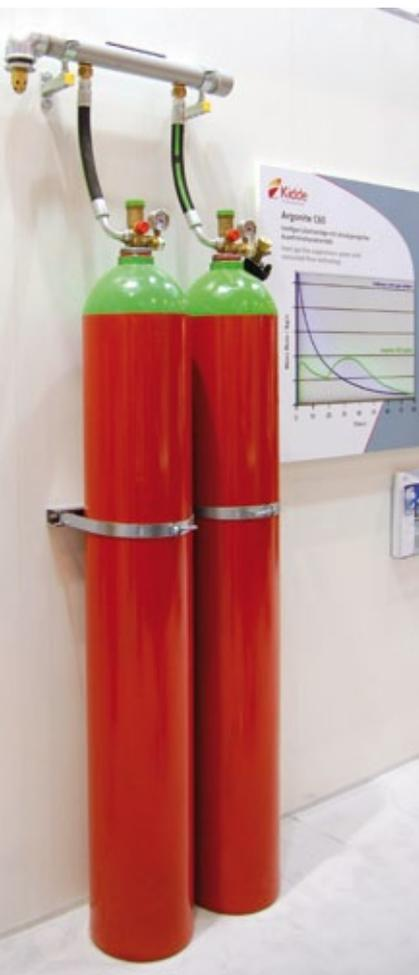
▲ Die Inertgas-Löschanlage Argonite C60 schützt sensible Technik
