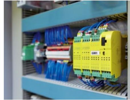
PSR-Trisafe ist bis PL e gemäß DIN EN ISO 13849-1 zugelassen
