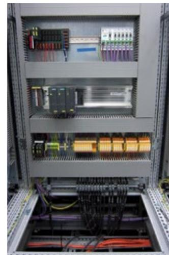
Überspannungsschutz der Profibus DP Leitungen durch Kombi-Ableiter Blitzductor
