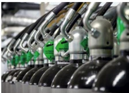
Das Löschesystem ist redundant aufgebaut und kann von der Ferne aus zurückgesetzt werden
