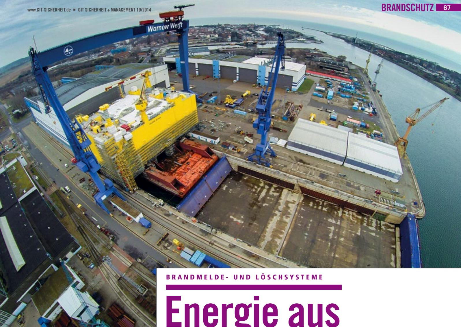
Die 67 Meter hohe, 56 Meter breite und 83 Meter lange Offshore-Konverterplattform wurde in der Werft Rostock-Warnemünde gefertigt
