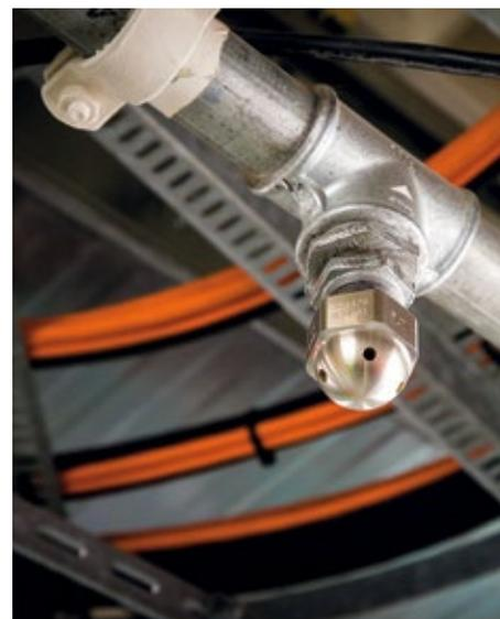
Im Brandfall werden automatisch Gas-, Schaum-, Sprinkler- und Sprühflut-Feuerlöschanlagen aktiviert
