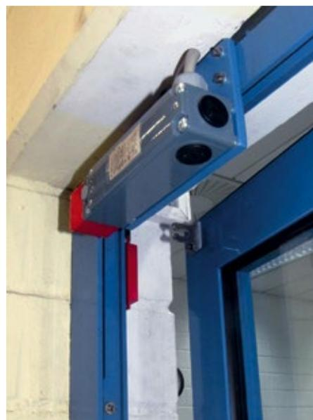
Vor den Türen wurden Heavy-Duty-Zuhaltungen L200 angebracht um sicherzustellen, dass kein Zutritt während des gefährlichen Tests stattfinden kann
