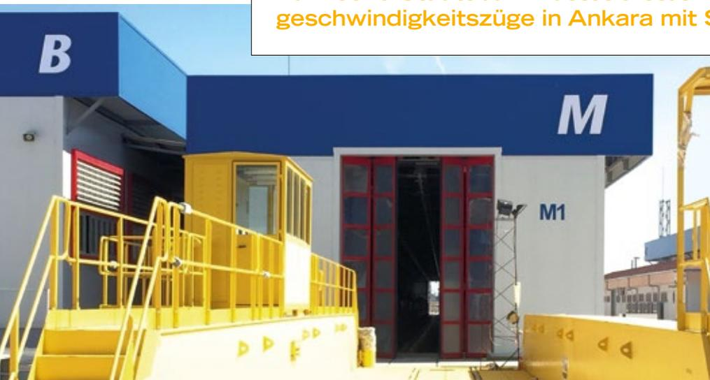
Zu den Auswahlkriterien zählten u.a. die Laufkultur der Tore, die Laufgeschwindigkeit sowie die Fahrdrähtauschnitte für die Durchführung der Fahrdrähte in die Hallen
