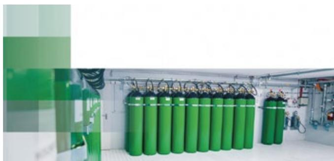
und schützt so vor brandbedingten Verlusten und betriebsgefährdenden Unterbrechungen. Durch die Verbindung von OxyReduct mit der Brandfrühsterkennung ermöglicht Wagner eine ganzheitliche Brandschutzlösung auf höchstem Niveau. Hochsensible Titanus-
