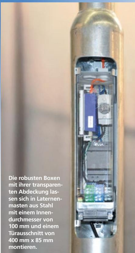
Die robusten Boxen mit ihrer transparenten Abdeckung lassen sich in Laternenmasten aus Stahl mit einem Innendurchmesser von 100 mm und einem Türausschnitt von 400 mm x 85 mm montieren.
