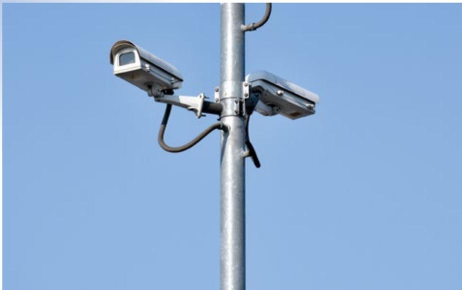
Mit dem Verkabelungssystem PE-Light können Überwachungskameras via Glasfasern an ein Netzwerk angeschlossen und über PoE+ mit Strom versorgt werden
