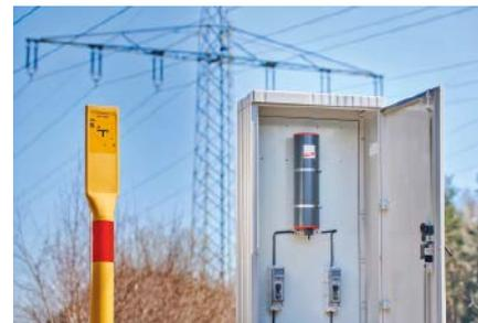
Einsatzbereich werden auf ein ungefährliches, sicherheitstechnisch vertretbares Maß begrenzt. Personen, die an der Pipeline arbeiten, sind so mit der Abgrenzeinheit vor gefährlichen Berührungsspannungen geschützt.
