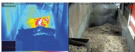
Zwei M15D Thermalkameras überwachen die Temperatur im Holzbunker und kontrollieren die Temperatur des Brennstoffes selbst
